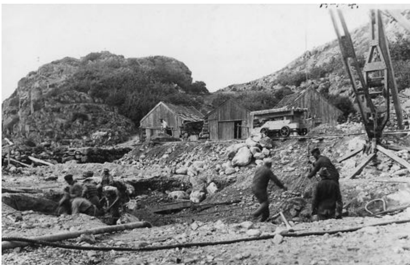
Då sjøen var pumpa ut av hamna, kunne arbeidarane arbeida på "tørt land".
