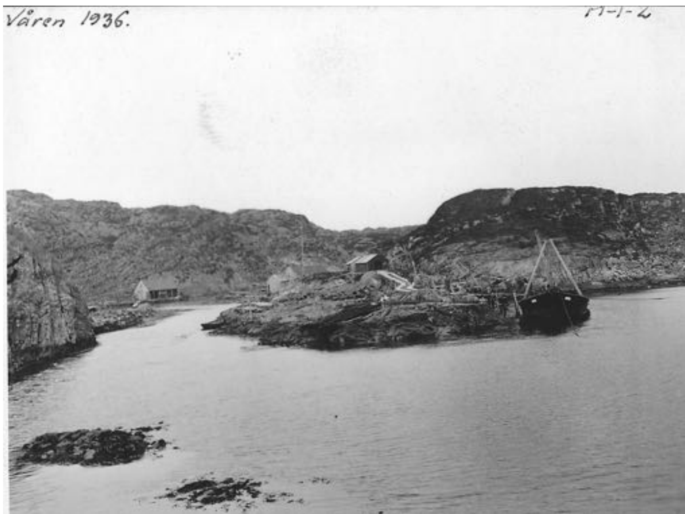
Tidleg i annleggsfasen. Ein føringsbåt ligg ved Bleikja og lossar utstyr.
