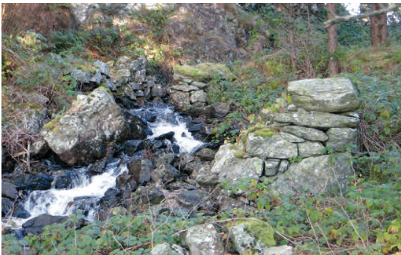
Ved bekken frå Sagvatnet og ned i Tjongepollen var det éi sag og tre kvernhus. Restane av grunnmurane står der den dag i dag. (Foto: B. E. Vika).
