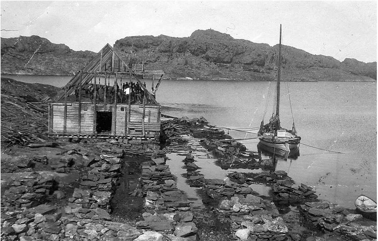
Arbeidet er i gang. Takkonstruksjonen vert demontert.
