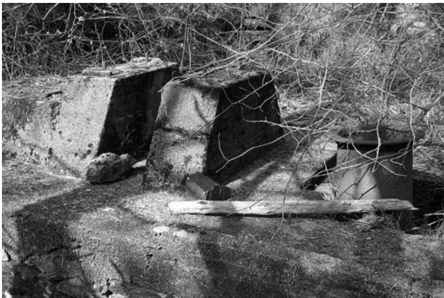
Fundamentet til kraftverket står enno (2014). Vatnet vart leda ut av kraftverket gjennom røyra til høgre på biletet. Foto B E Vika
