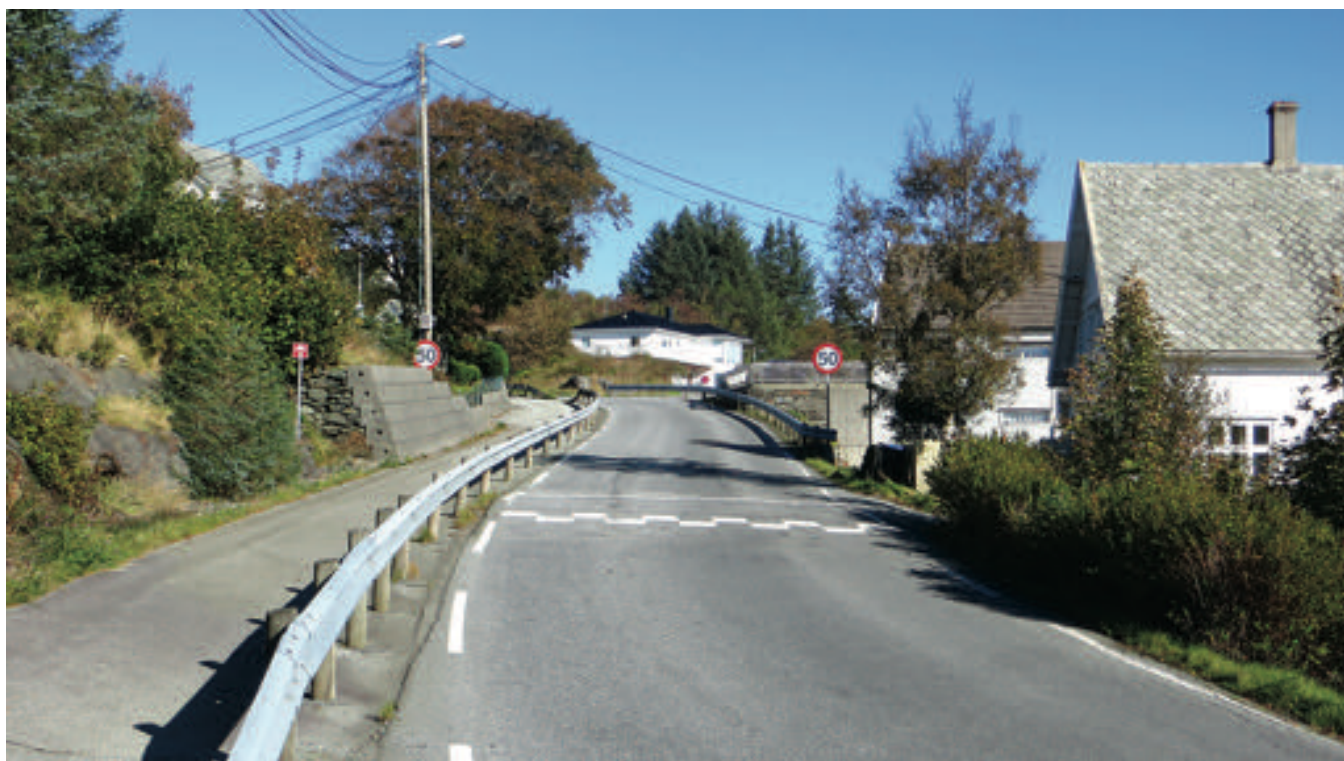
Olsabrekka i 2016. Bergene der bedehuset stod, til venstre på biletet, er skote bort for å gi plass til breiare veg og gang- og sykkelsti. (Foto: Bernt Emil Vika)
