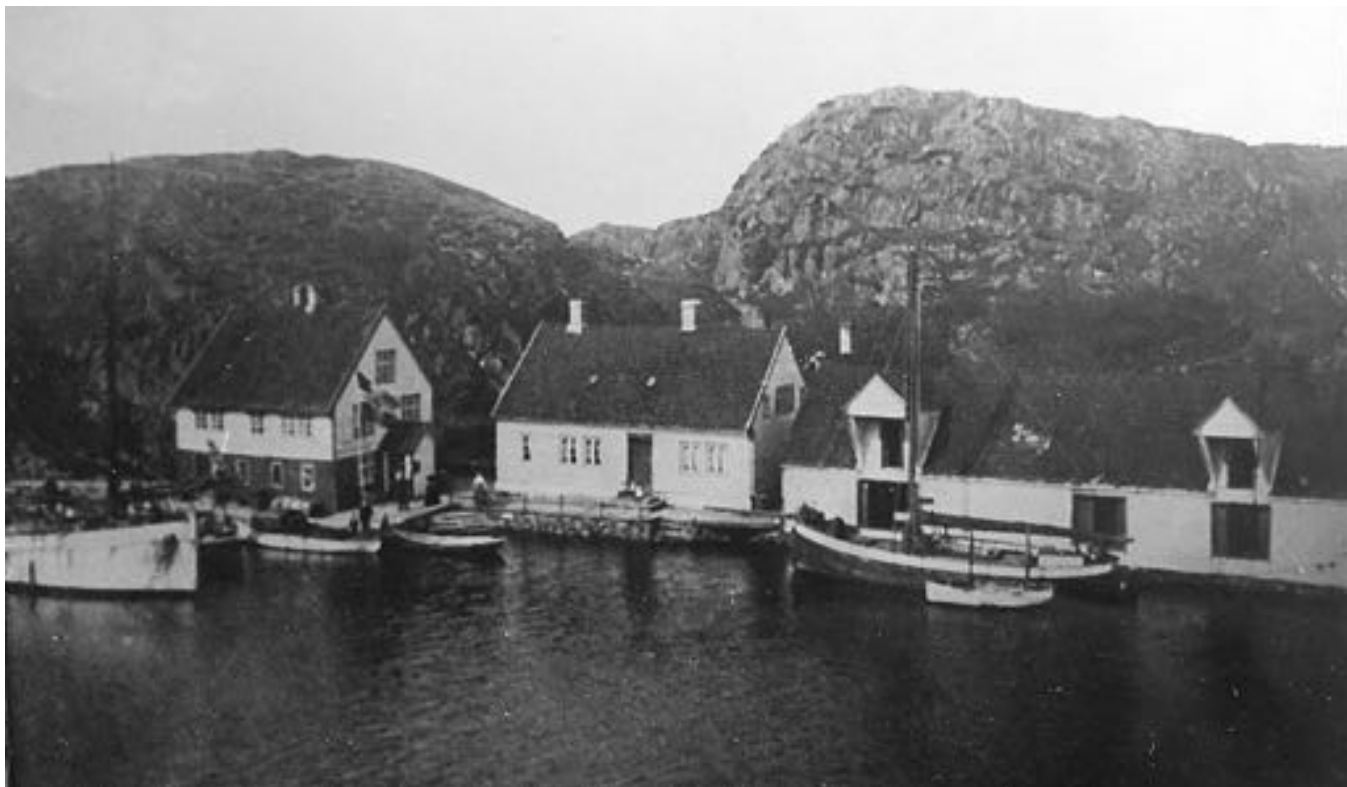
Biekronå i 1912. Huset til venstre vert kalla Strandbu, og det i midten er hovudbuset i den gamle handelsstaden som ein gong låg her. Bernhard Bie budde i begge desse busa. Huset til høgre går under betegnelsen Biehuset. Her hadde Bernhard verkstaden sin i loftsetasjen. (Foto frå Rolf Nesse).
