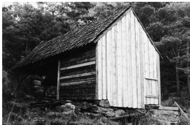
Saga ved Vorlandsvågen
