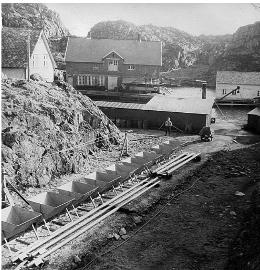
Dette er ein leveranse til as Protan i Drammen. Det er utstyr til taremttak, master, bommar og vektassar. Biletet gir også fin oversikt over området. Vi ser både sveiserommet og stållagert til Jobs. Mæhle og verkstadbygget til "Slippen".
