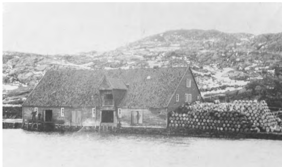
Sundtahuuset på Kalavåg. Dette er ei av dei siste saltebuene som framleis står att her i distriktet.
