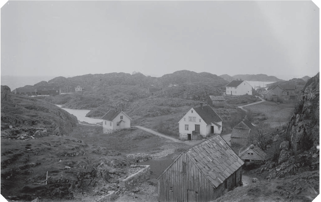
Dette bildet viser begge gardsbruka på Espevær, br.nr. 1 nærast og br.nr. 5 bortanfor. I bakgrunnen til venstre kan ein sjå Rognahuset, eit stort salteri med bødkerverkstad, br.nr. 73. Huset til venstre framme var vilkårshus for br.nr. 1. Biletet må vera tatt ein gong mellom 1910 og 1912.
