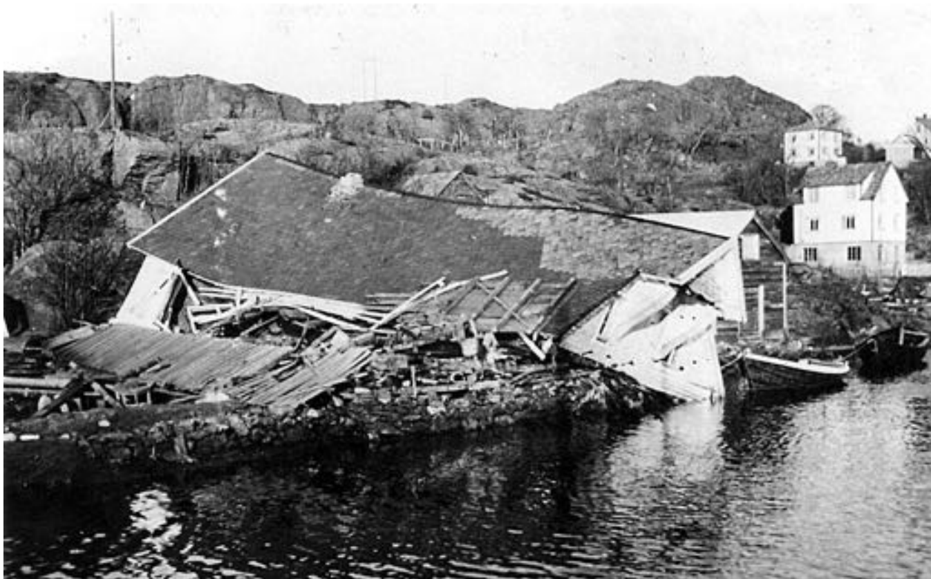
Huset til Knut Mathias Knutsen Kallevåg bles ned i ein orkan 15. januar 1952. Foto frå Einar Kallevåg
