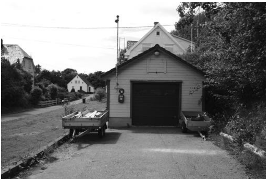
Espevær fekk sitt eige brannvern nesten ti år før det kommunale brannvernet såg dagens lys. Brannstasjonen ligg sentralt på øya.
